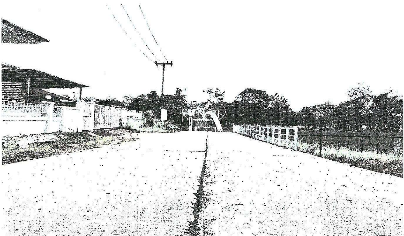
โครงการซ่อมสร้างถนน คสล. สายทางเข้าสะพานโค้งเข้าเกาะกลางอ่างเลิงซิว หมู่ที่ 13
