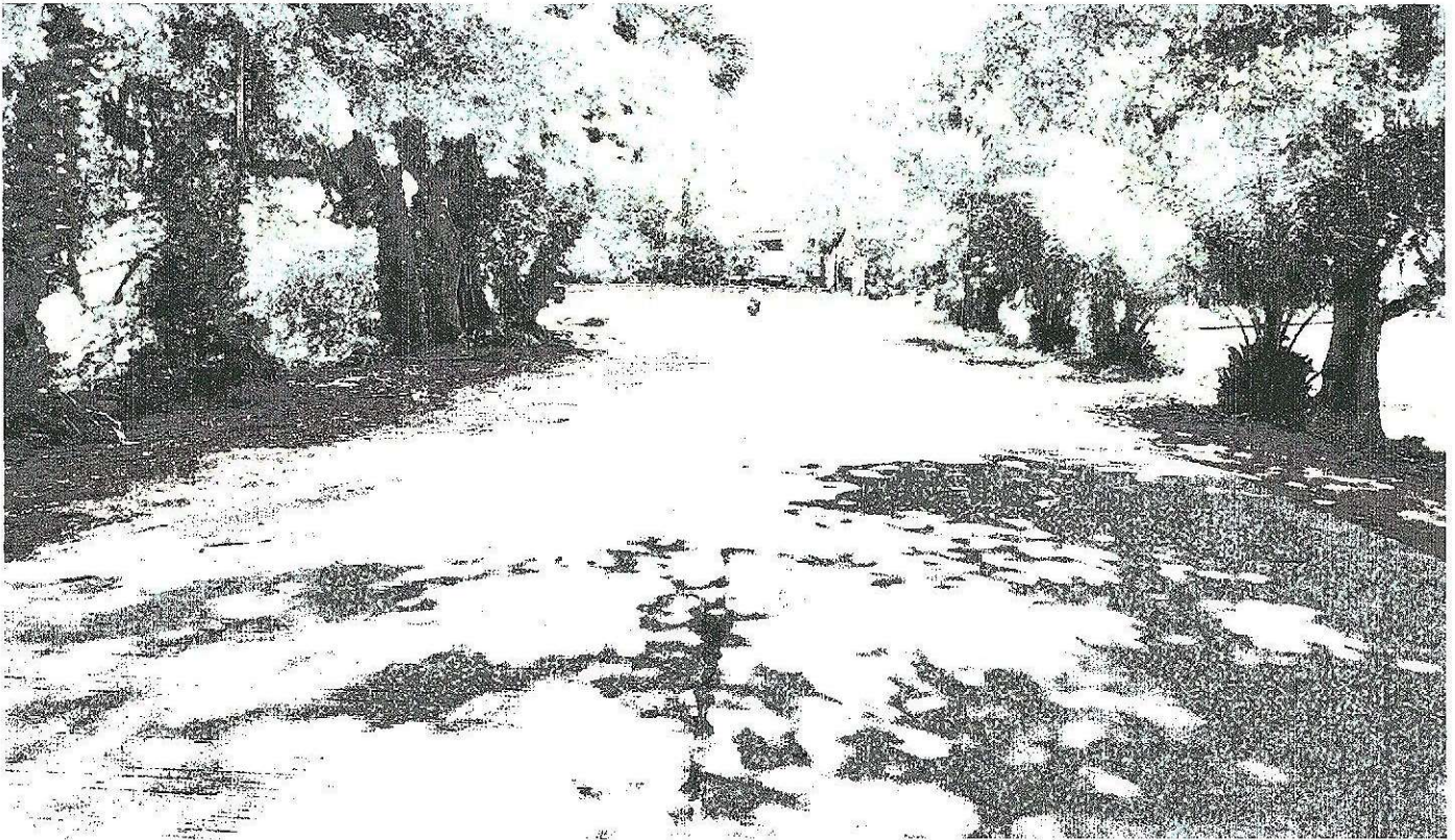
โครงการซ่อมสร้างถนน คสล. รหัสทางหลวงท้องถิ่น กส.ถ. 36-008
